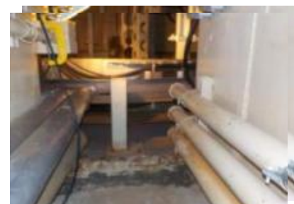
作業員アクセス開口部
