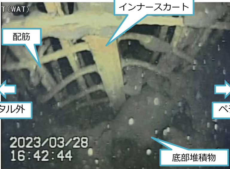
写真2.ペDESTAL開口左側配筋
