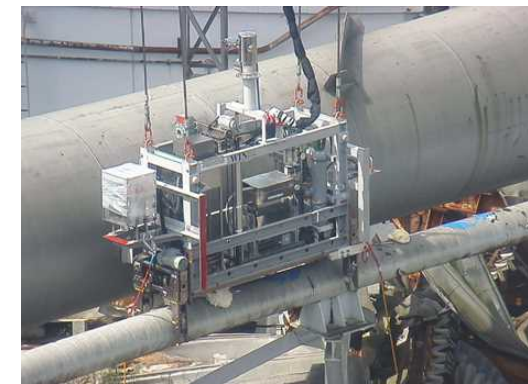
写真：2021年9月ウレタン注入時
