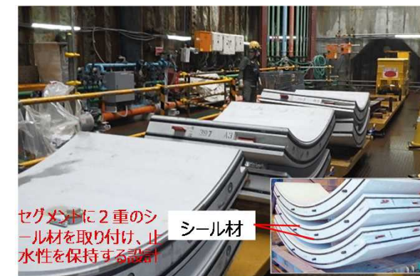
セグメント搬入状況
