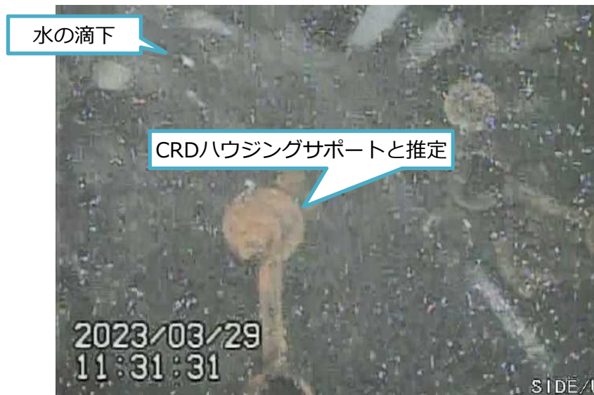
写真2. CRDハウジングサポートと思われる構造物 (上側カメラで気中を撮影)
