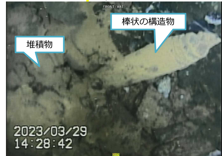
写真3.棒状の構造物(ペDESTAL底部)
