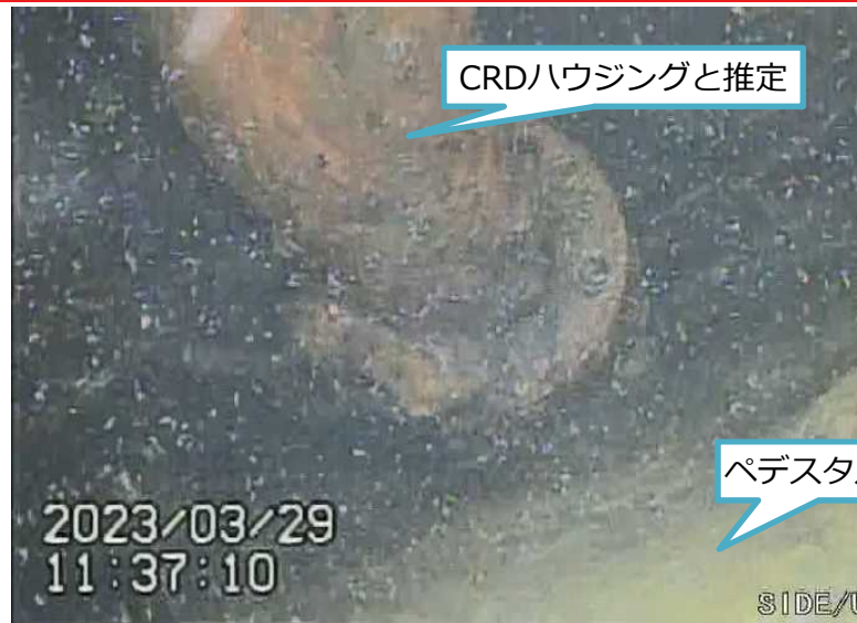
写真1. CRDハウジングと思われる構造物 (上側カメラで気中を撮影)
