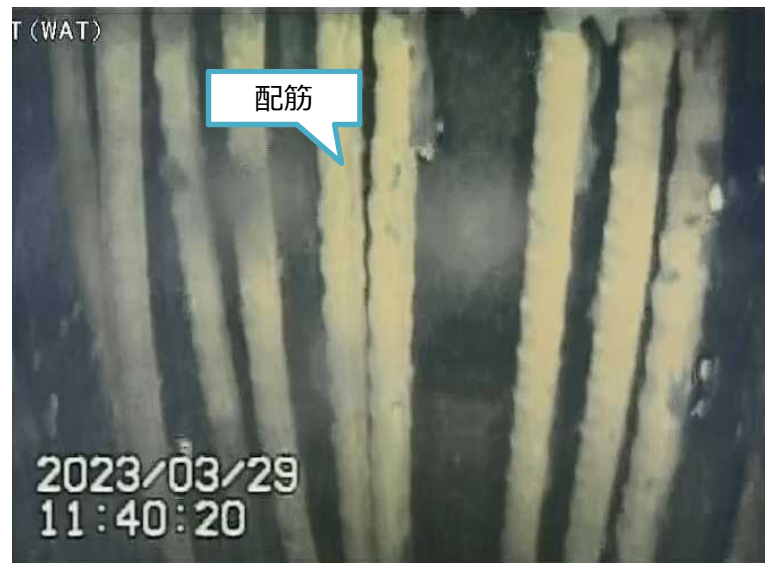
写真2.ペDESTAL内基礎部(下部)
