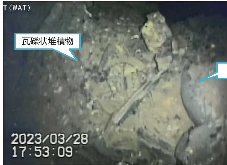
写真2.ペDESTAL内開口付近堆積物
