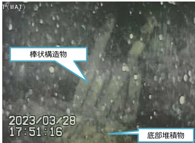
写真1.堆積物上の棒状構造物 (ペDESTAL開口部内にて撮影)
