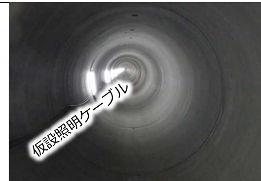
排水路推進トンネル完成状況
