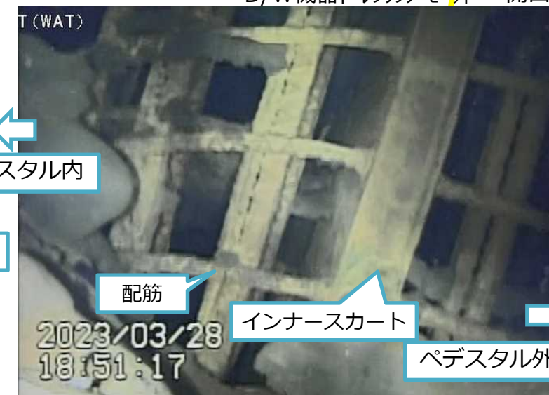
写真3.ペDESTAL開口右側配筋
