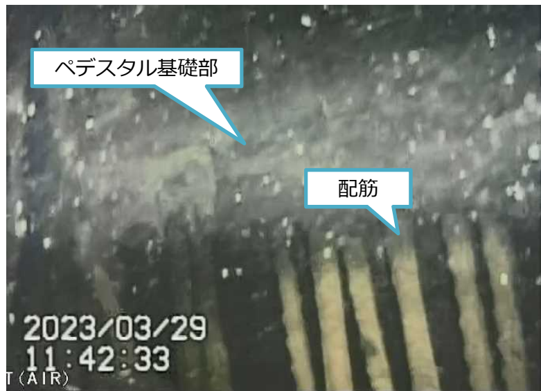
写真1.ペDESTAL内基礎部(上部)
