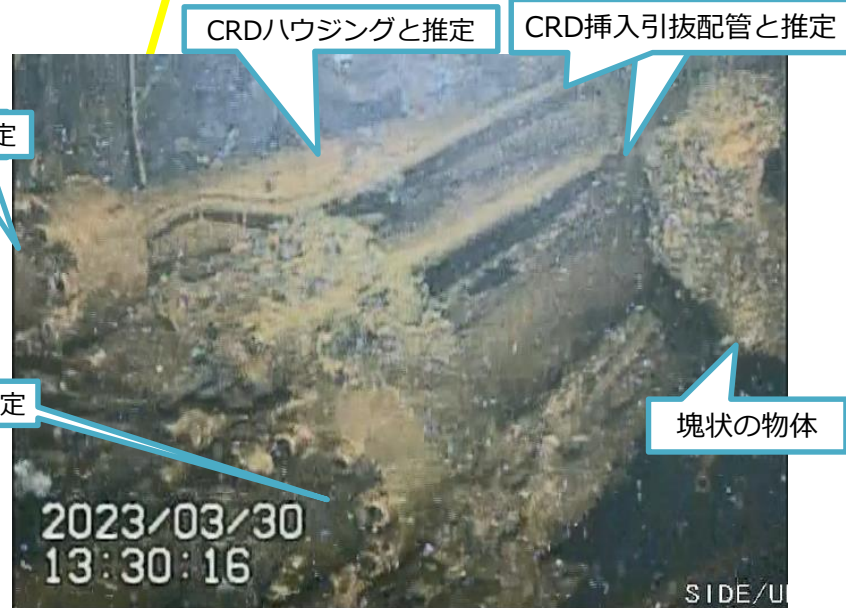
写真3. CRD関連と思われる構造物 (上側カメラで気中を撮影)
