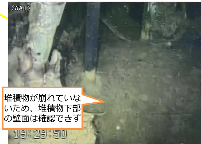
写真6. 遮へい板裏ペDESTAL壁面 (堆積物周辺)
