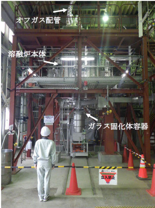
写真-1 3号熔融炉設置状況
