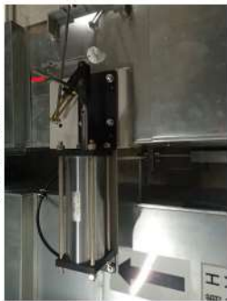
中央制御室排気隔離ダンパ
