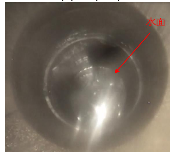
③RCW-Hx(C)入口(垂直)配管の水面
