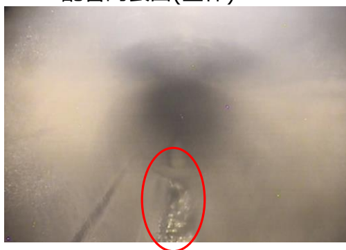
①RCW-Hx(A)(B)側の配管底部の堆積物
