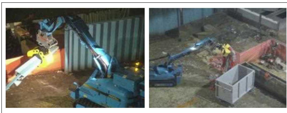
図：2号オペフロ残置物移動の様子
