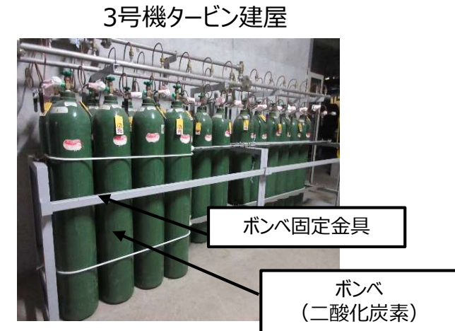
図17 発電所におけるポンベの設置状況
