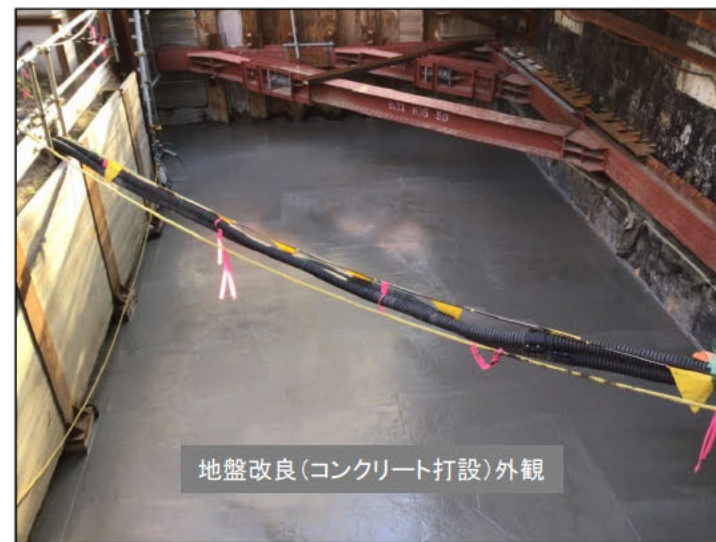
地盤改良工事の状況(令和3年12月)
