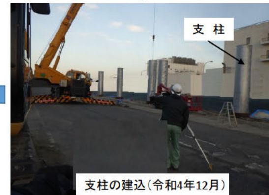
津波漂流物防護柵（引き波）の設置工事の進捗状況（令和5年1月）
