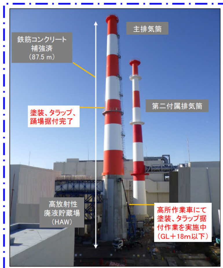
主排気筒の筒身補強工事の状況 (令和5年2月)
