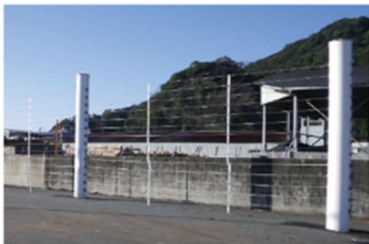
津波漂流物防護柵の設置イメージ
