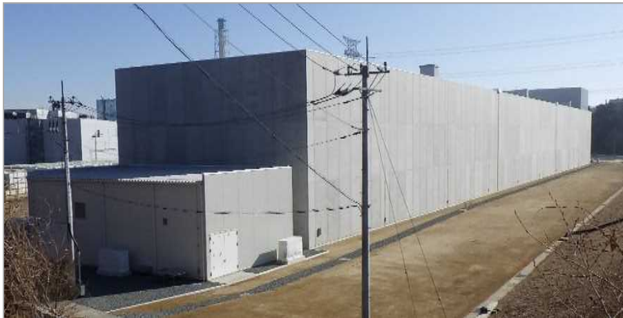
【現場状況：北面・西面】
