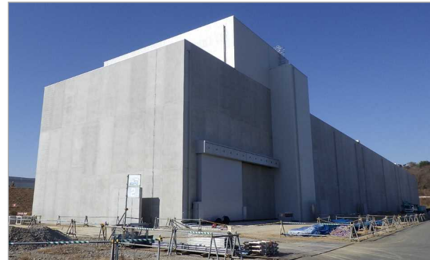
【現場状況：南面・東面】
