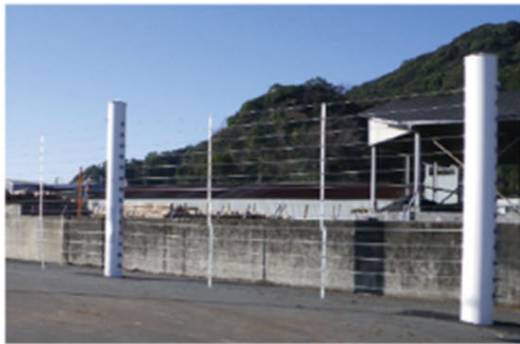
津波漂流物防護柵の設置イメージ
