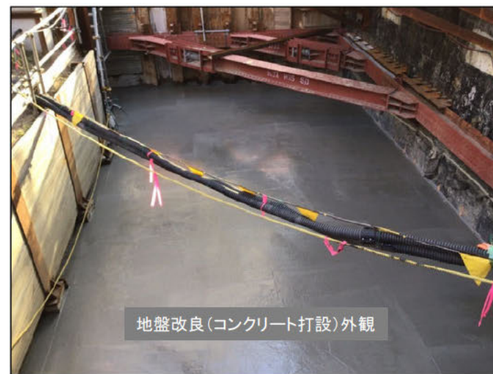
地盤改良工事の状況(令和3年12月)
