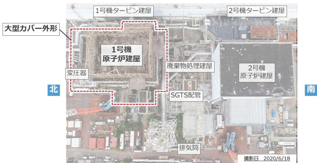
図4 1号機原子炉建屋周辺状況（2020年6月時点）
