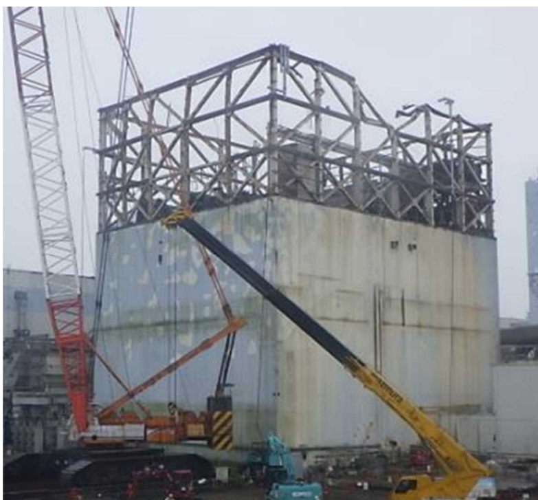
图 1-2 1号機原子炉建屋全景（2021年6月19日時点）
