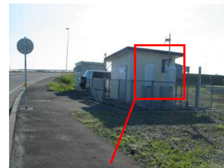
電離箱検出器及びNaI(Tl)シンチレーション検出器。新設防潮堤との距離は新設防潮堤に近い検出器で代表している。
