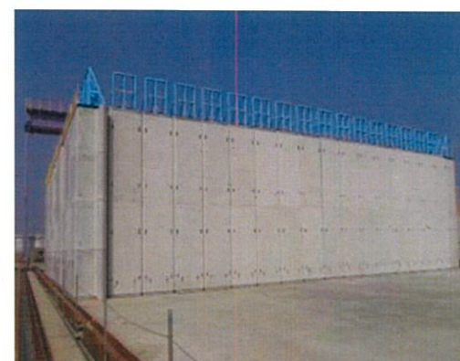
<第三施設外観 (南面)>
