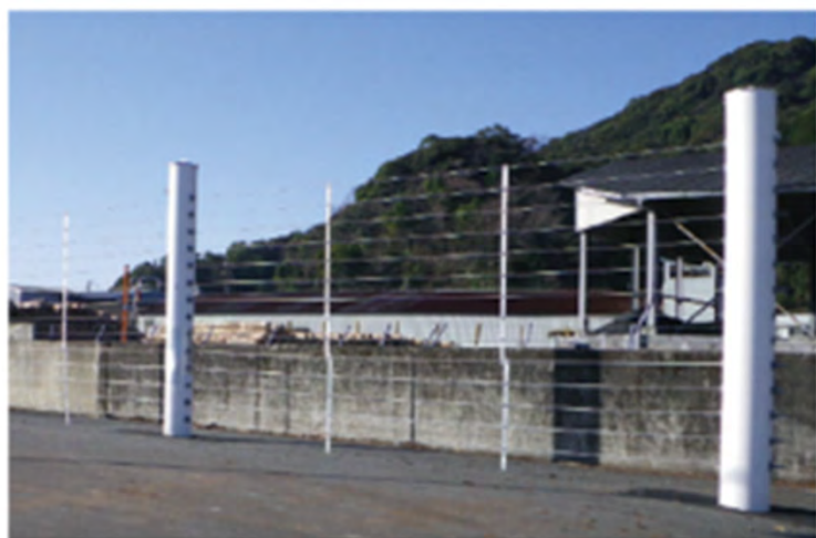
津波漂流物防護柵の設置イメージ
