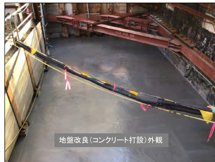
地盤改良工事の状況(令和3年12月)
