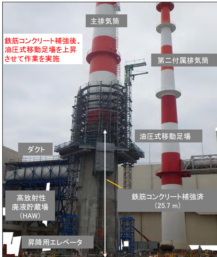
主排気筒の筒身補強工事の状況 (令和4年4月)
