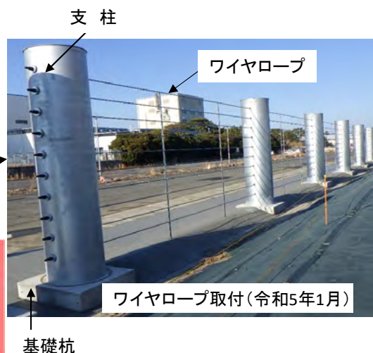
津波漂流物防護柵(引き波)の設置工事の進捗状況(令和5年1月)
