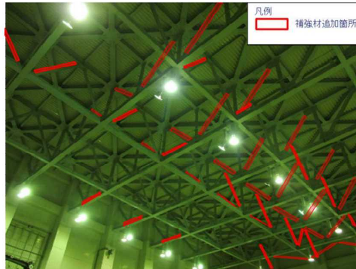
原子炉建物耐震補強工事状況
