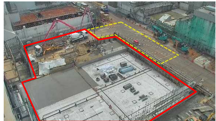
<テープ表示箇所を避けた作業（コンクリート打設）>
