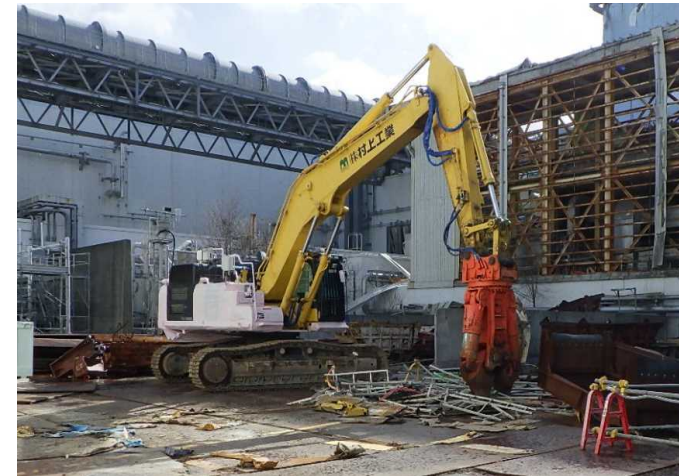
<遠隔操作重機>
