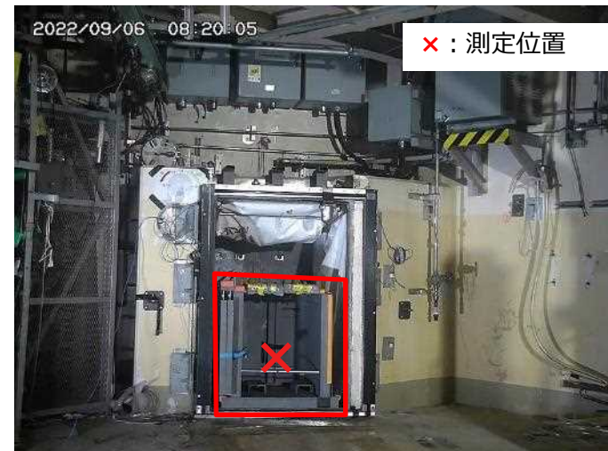
<箱型ゴム交換作業用遮蔽体>
