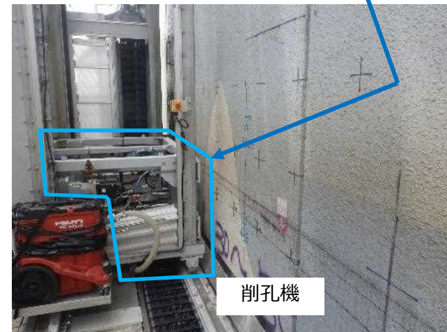
<現場削孔状況>
