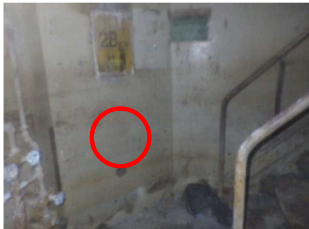
4号機R/B地下階北西部
