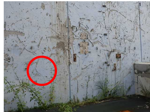
4号機R/B西側外壁屋外側
