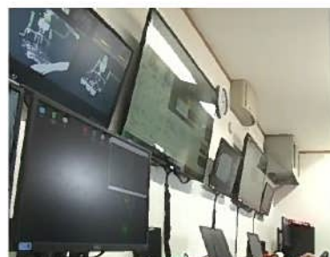
コンテナハウス内
