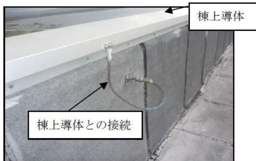
循環水ポンプ建屋
