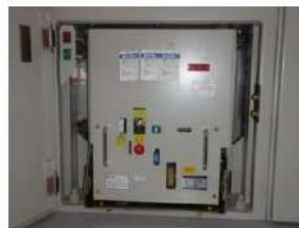
原子炉トリップ遮断器
