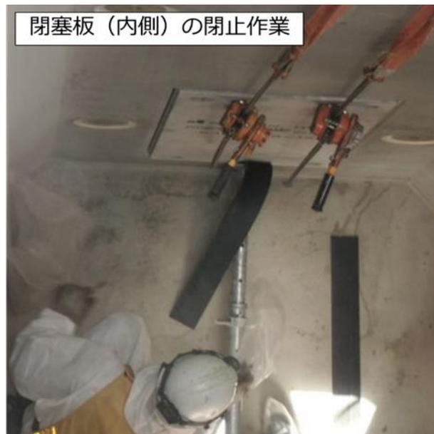
図 2.14.1-5 閉塞板による閉止状況
