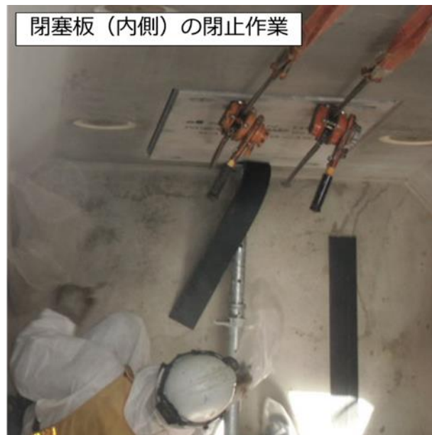
図 2.14.1-5 閉塞板による閉止状況
