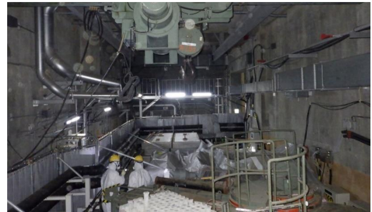
ハッチ付近（ROV投入箇所）
