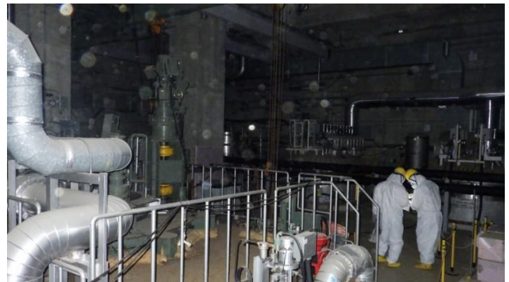
建屋西側付近（容器搬出入箇所）
