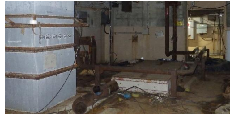
中央ハッチ付近（ROV投入箇所）
