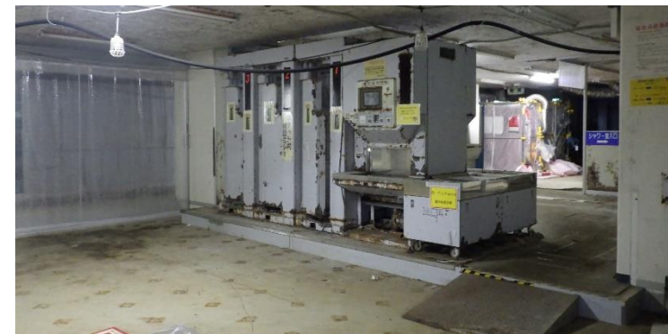
補機設置予定エリア付近
