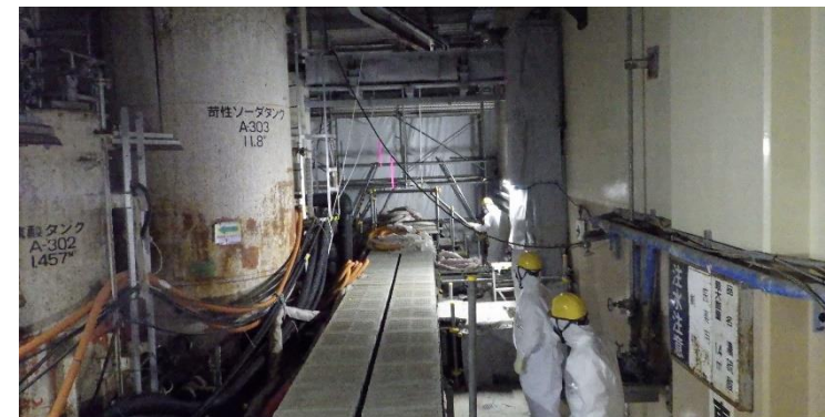
建屋北西付近（容器搬出入箇所）
