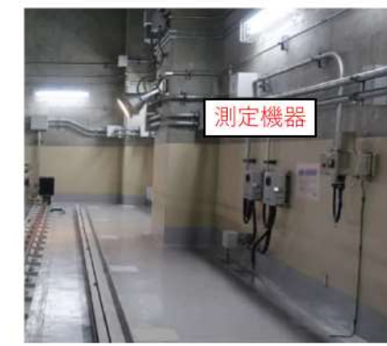
⑦使用済燃料ピット周り
