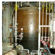
排水処理設備の例 (廃液槽)
