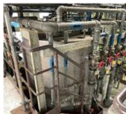
オフガス処理設備の例 (スクラバ)
