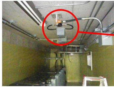
水素濃度検知器（蓄電池室の例）
