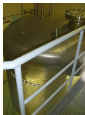
廃樹脂供給タンクエリア
