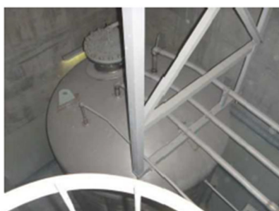
廃樹脂貯蔵タンク
