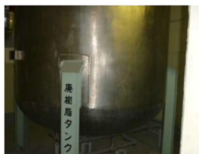
廃樹脂タンクエリア
