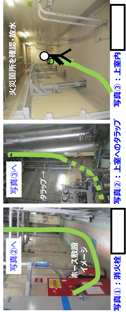
図 4：冷却材脱塩塔室近傍の消火器及び消火栓の配置図
