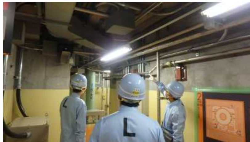
現場確認の例②
