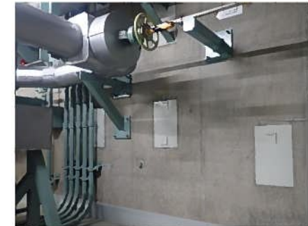
原子炉補助建屋 外壁（2号炉）
