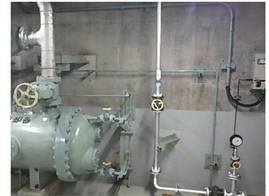
原子炉補助建屋 内壁及び床 (2号炉)
