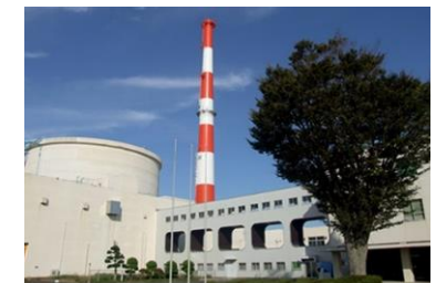
高速実験炉「常陽」
