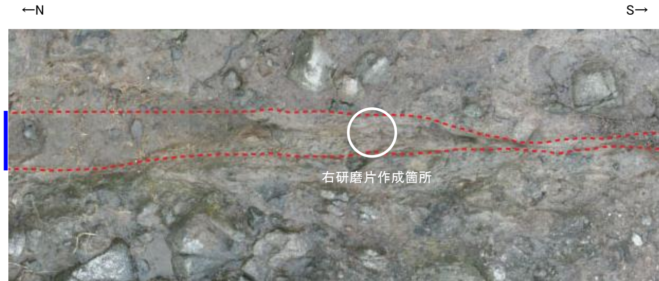
固結した破碎部
