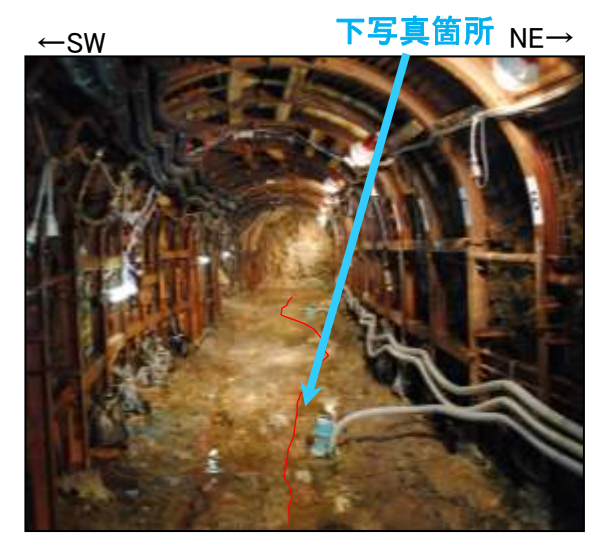
岩盤調査坑写真(全景写真)
