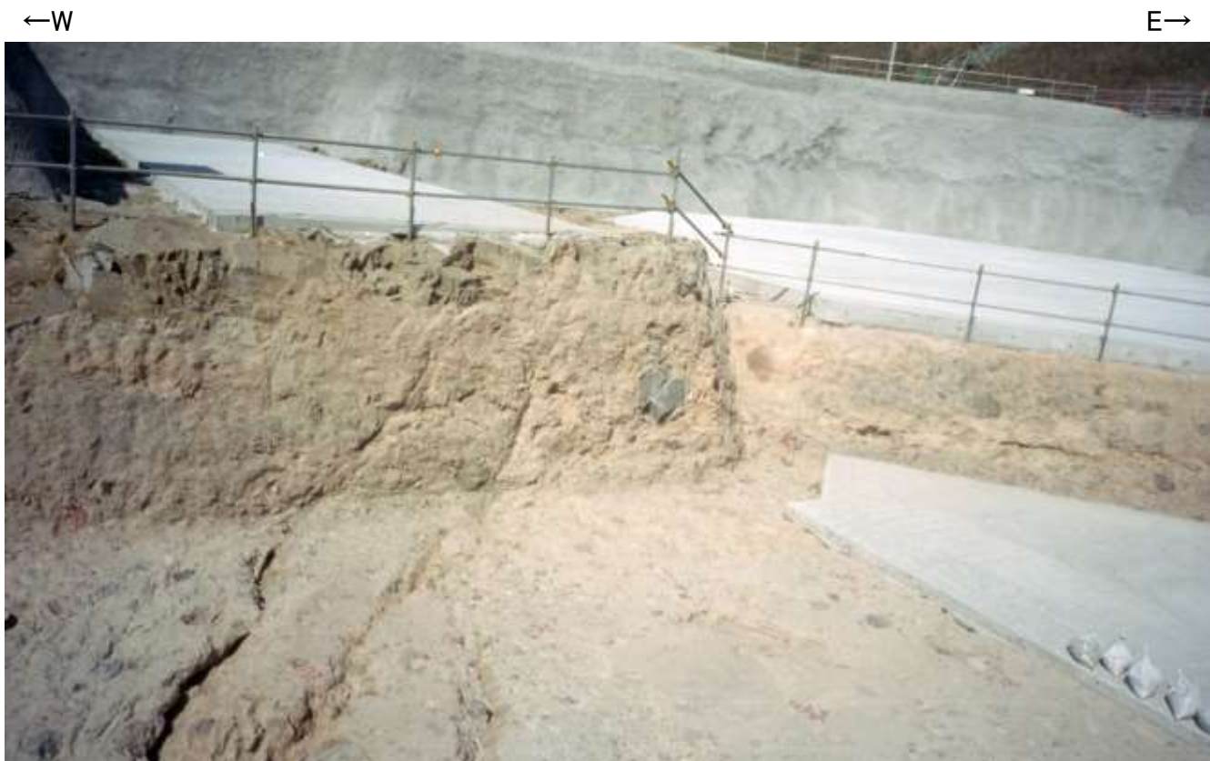
写真① S-4付近写真
