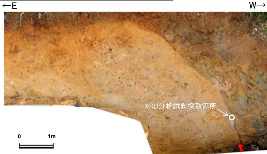
試料採取箇所(大坪川ダム右岸北道路)
