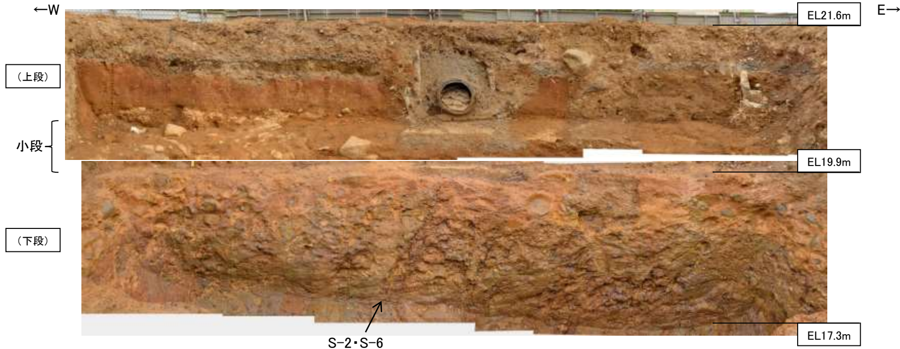
写真(No2トレンチ 北面)
