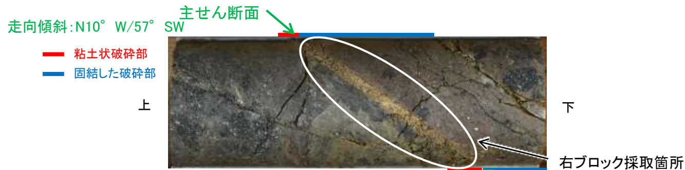
ボーリングコア写真(F-6.75孔)
