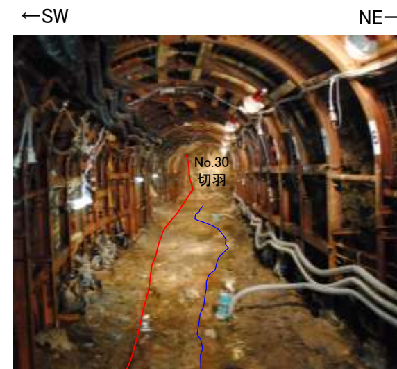
横坑の状況写真 (立坑側より, 2013年撮影)
