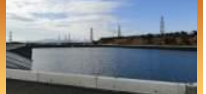
淡水貯水池設置
