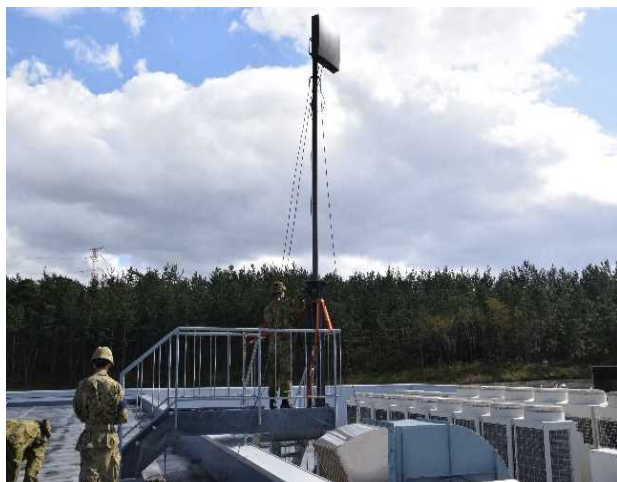
屋外アンテナの設置
