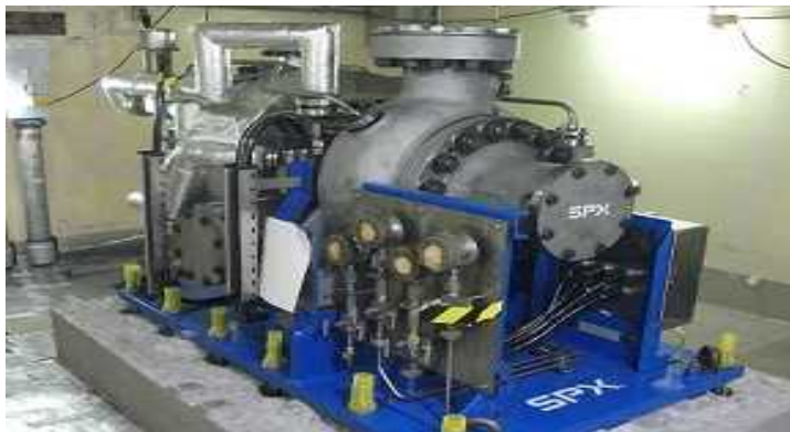
電源不要で原子炉の蒸気で原子炉に注水できるポンプ <熱交換器車>
