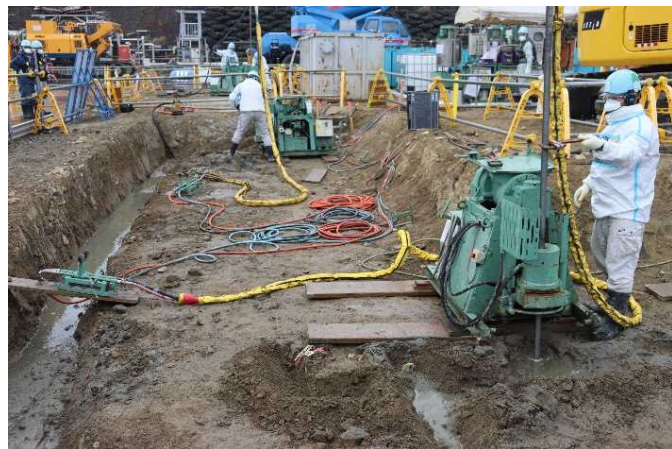
地盤改良の状況
