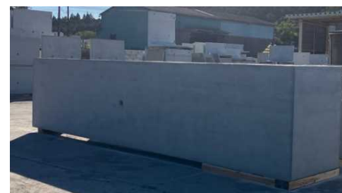
上流水槽側壁
