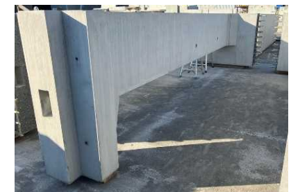
上流水槽隔壁
