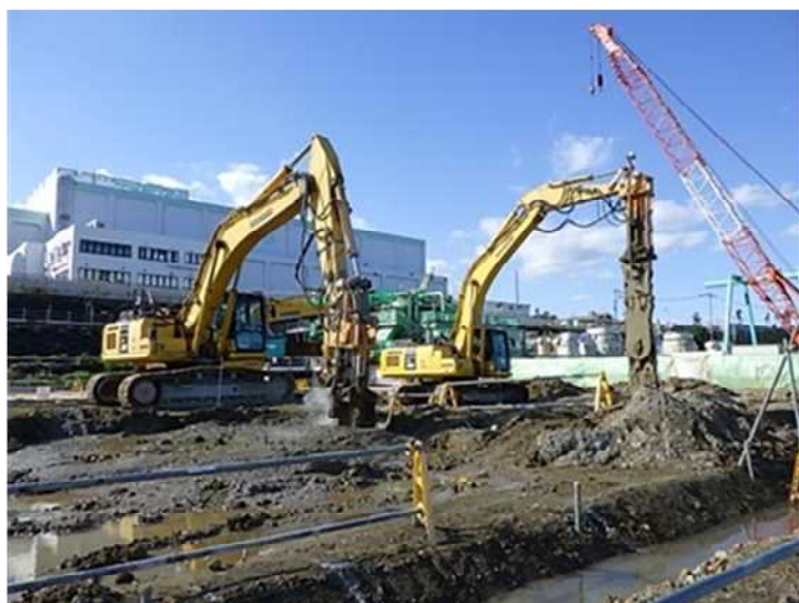
地盤改良の状況
