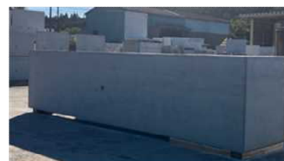
上流水槽側壁
