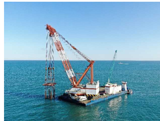
放水口ケーソンの据付工事の様子④
