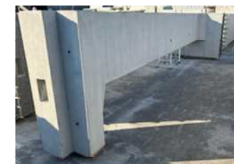
上流水槽隔壁
