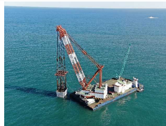
放水口ケーソンの据付工事の様子③
