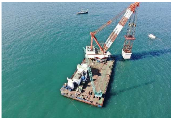
放水口ケーソンの据付工事の様子①
