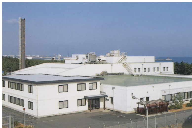
FNS棟の外観
