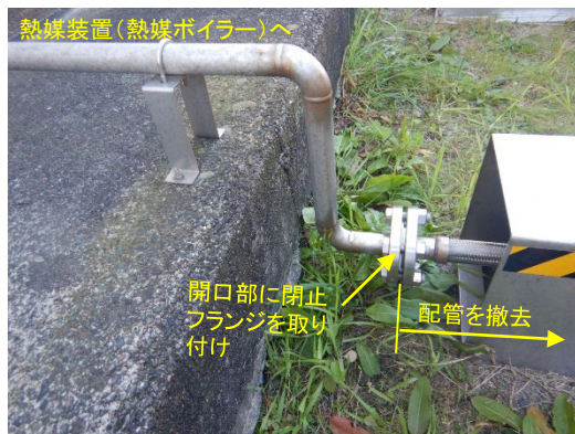
① LPG配管を閉止フランジで閉止する。
