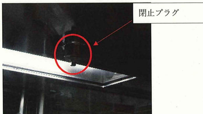
図-2 低放射性グローブボックス消火配管接続口 (内側)
