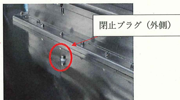
図-1 低放射性グローブボックス消火配管接続口 (外側)
