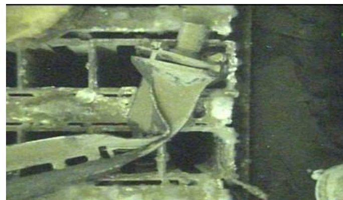
制御棒下部に変形
