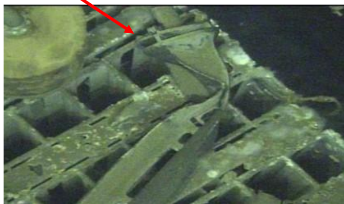
制御棒下部に変形
