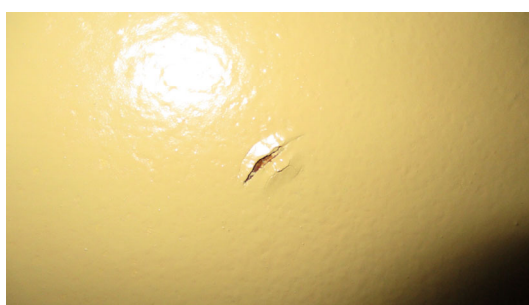
フロー②と判断した塗膜の劣化
