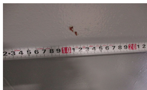
フロー②と判断した塗膜の劣化
