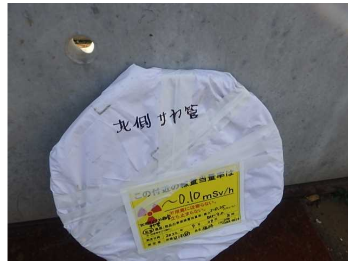
養生後 さや配管
