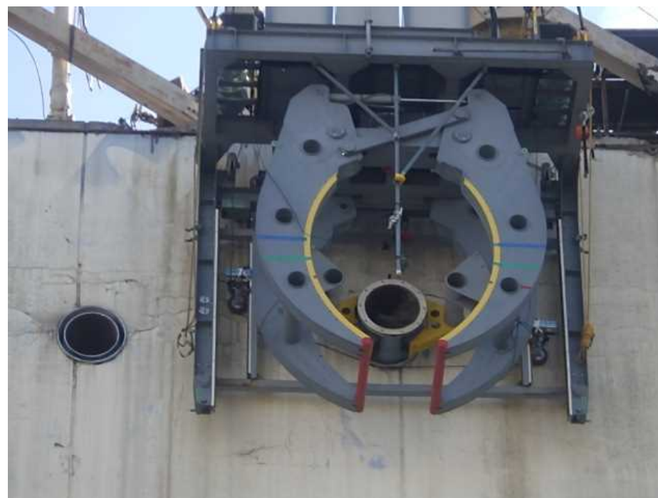
現場状況（南側IC配管切断） (撮影：2022年9月29日)
