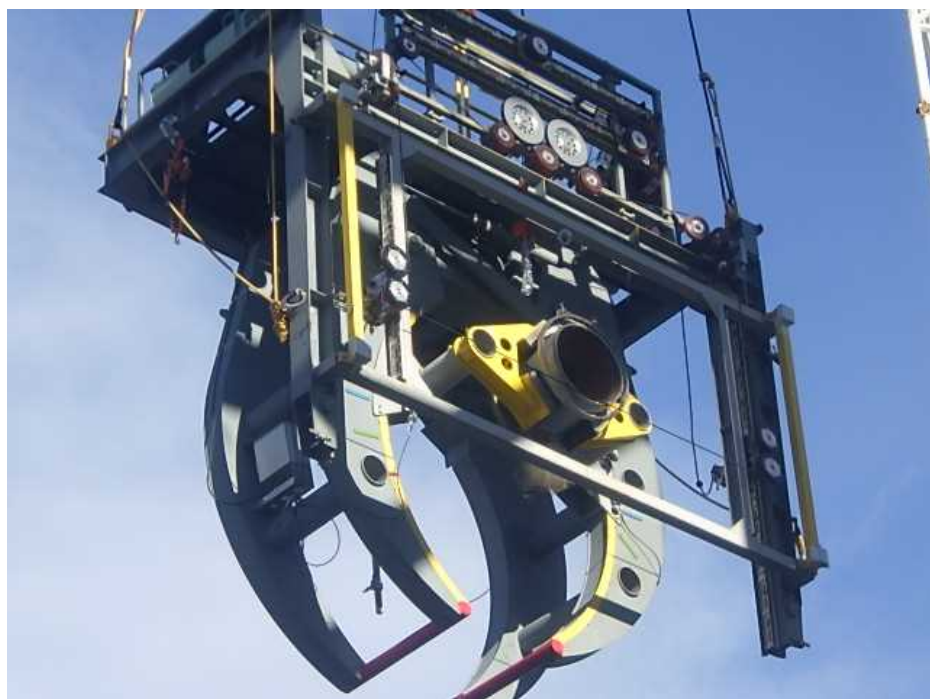
現場状況（北側IC配管吊降ろし） (撮影：2022年9月29日)
