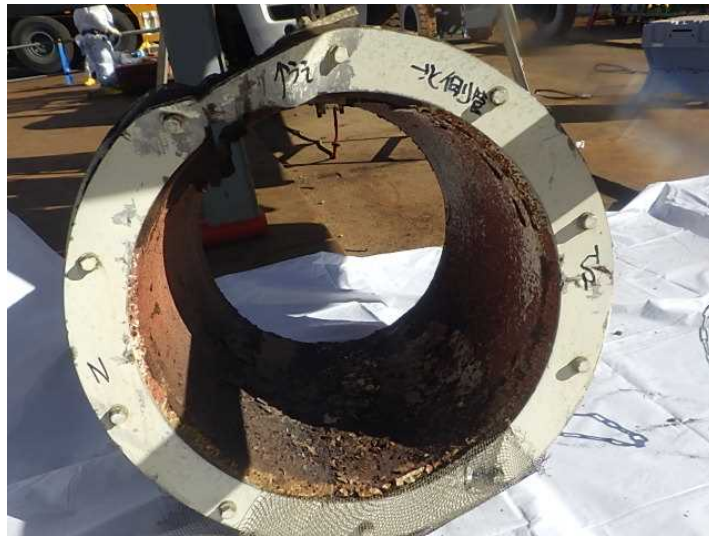
撤去後 IC配管
