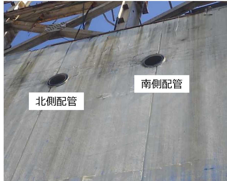
現場状況（西面） (撮影：2022年9月29日) (撤去後)
