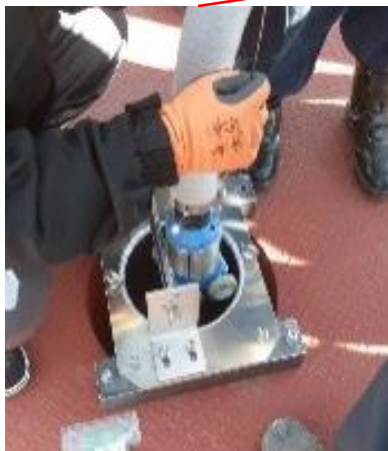
配管内アクセス装置挿入(3階)
