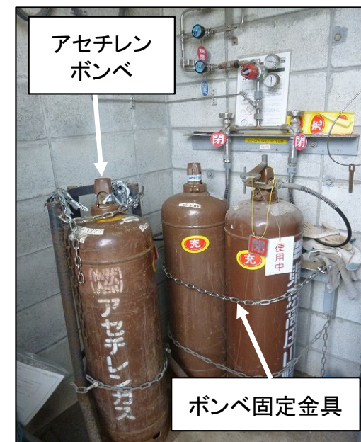
図18 敷地内におけるボンベの設置状況
