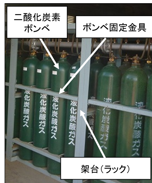
図18 敷地内におけるボンベの設置状況
