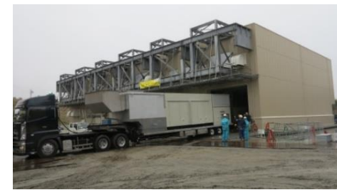
ガスタービン発電機
