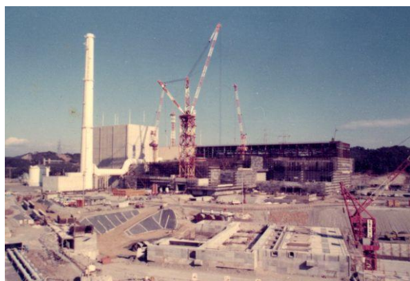
2号機建設工事中
