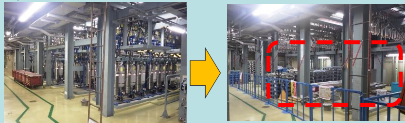
○浜岡 2 号機制御棒駆動水圧制御ユニット解体 (原子炉建屋内)
