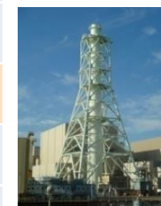
排気筒改造工事
