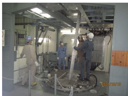
安全板取り外し 炉心タンクに上蓋設置
