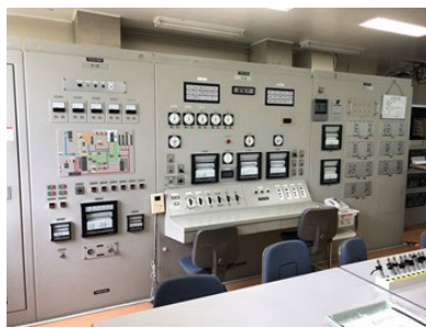
制御盤撤去前
