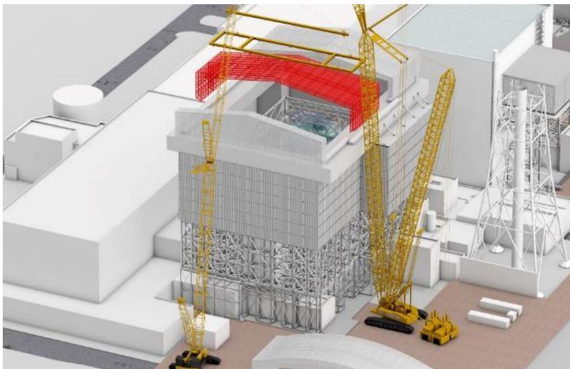
可動屋根設置中
