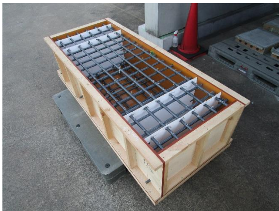
引抜試験体 打設前
