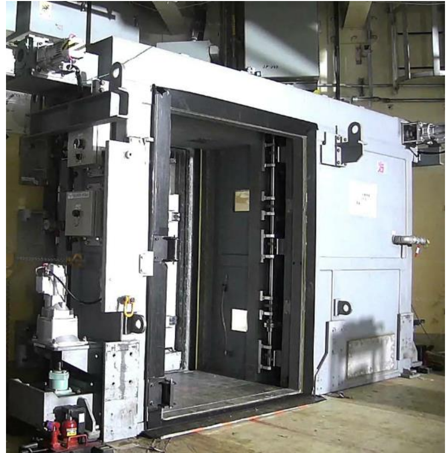
隔離部屋②の設置状況
